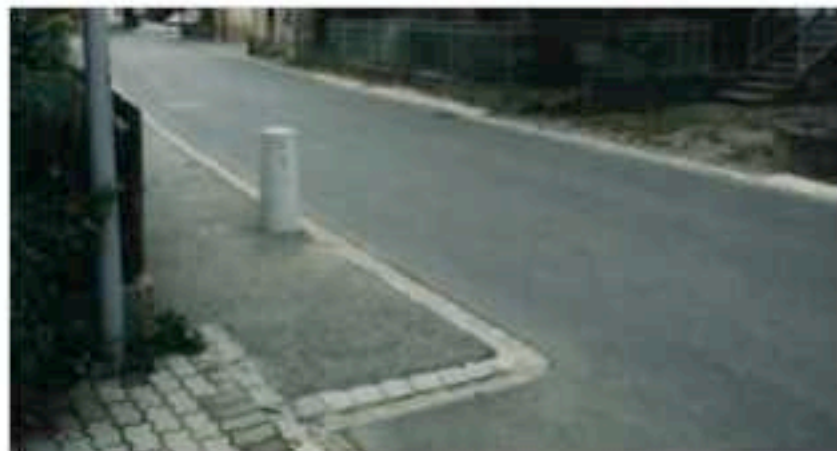
Fahrbahnverengung mit Wehrstein
