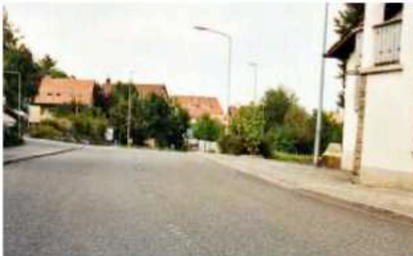
Entfernung der Mittelstreifenmarkierung
