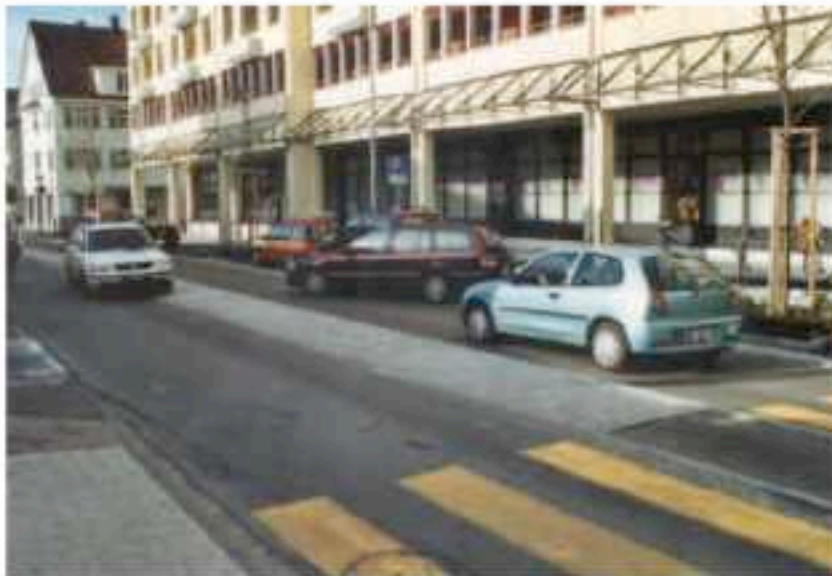
Ausweichstelle Mittelstreifen: Zum Überholen von Fahrrädern und Ausweichen von Parkmanövern.
