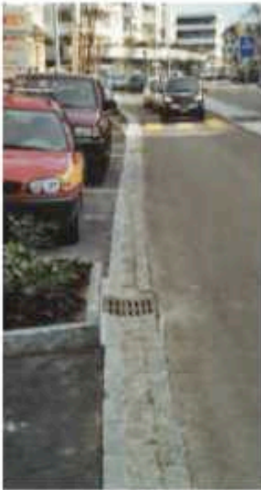
Längsparkierfelder im Zentrumsbereich
