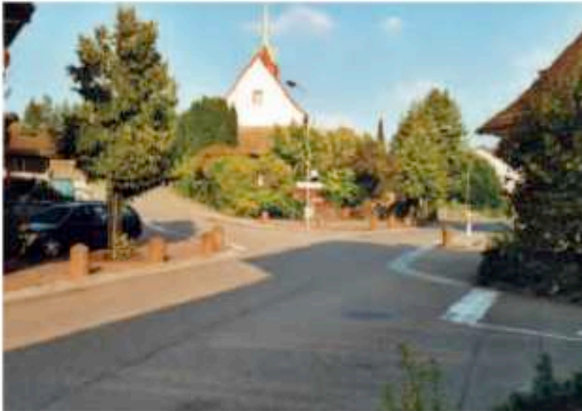
redimensionierte Einmündung, geschützt mit Wehrsteinen
