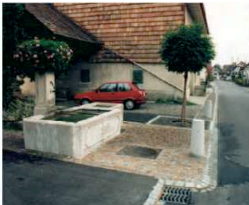
Dachsen (ZH): Fahrbahnverengung bei Brunnenplatz
