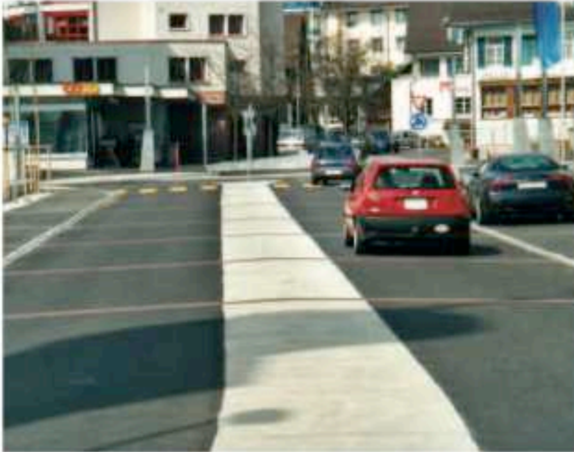
Strasse mit Verkehrstreifen in Fahrbahnmittle, Steinhausen (ZG)
