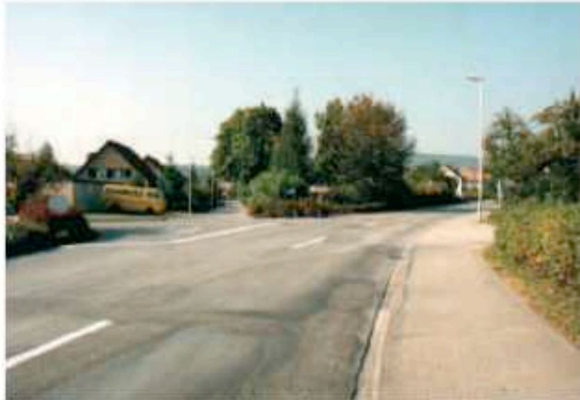
Dorfeinfahrt mit unübersichtlicher Einmündung
